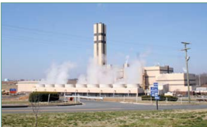
МСЗ «Кованта» (Covanta) в округе Фейерфакс (Fairfax), США. Построен в 1990 г., электрическая мощность 2 × 62 МВт, четыре линии производительностью 275 тыс. т/год каждая
