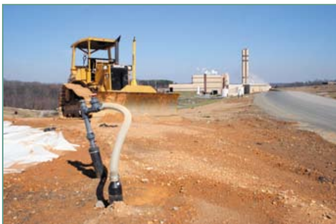
На заднем плане – МСЗ «Кованта». На переднем плане – газосборная скважина на полигоне ТБО I-95 (в 2006 г. было захоронено 22 млн т ТБО)
