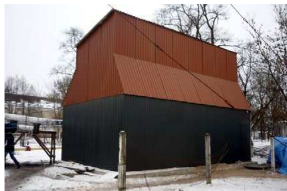
б) модульна котельня на гранулах
