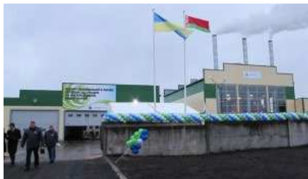
Рис. 4.7. Котельня в м. Славутич.
