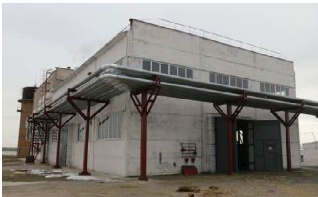
Рис. 4.2. Котельня птахокомплексу «Дніпровський» в Нікополі, Дніпропетровська обл.
