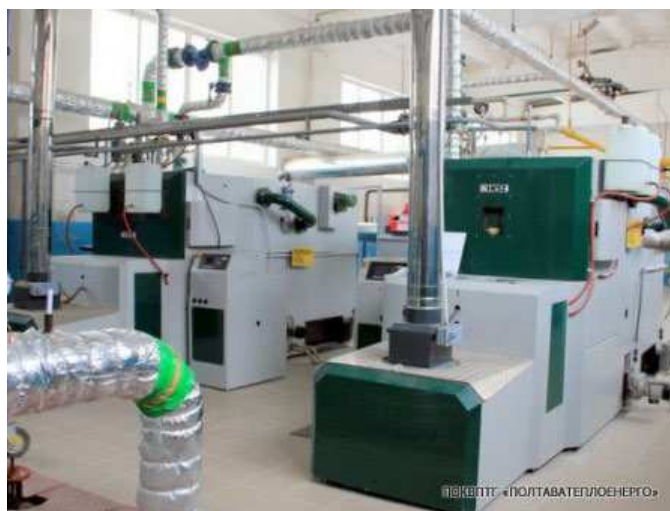
Рис. 4.12. Котельня на біомасі ПОВПТГ «Полтаватеплоенерго».
