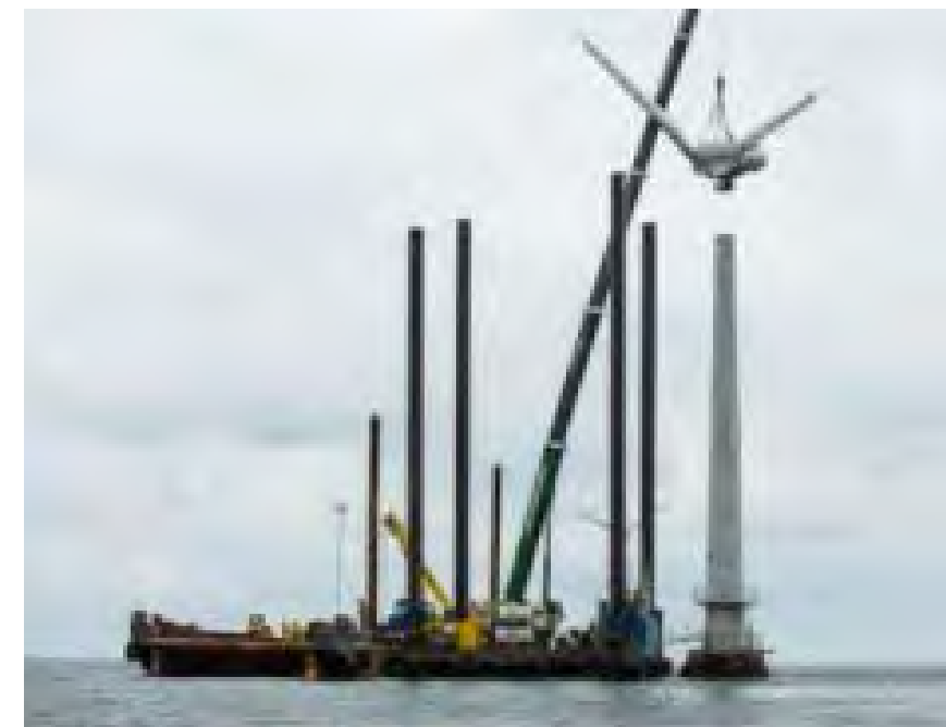
Демонтаж ВЕС «Vindeby» компанією DONG Energy
