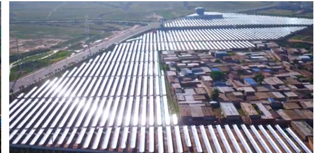
Baotou, Китай: 65 МВт(т), найбільша з концентраційними колекторами. Забезпечує ЦТ
