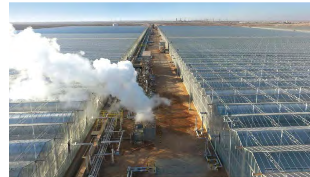
Miraa, Оман: 300 МВт(т), найбільша в світі промислова сонячна теплова станція (галузь-нафтопереробна промисловість)
