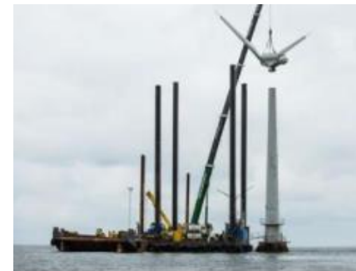
Демонтаж ВЕС «Vindeby» компанією DONG Energy
