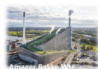
Amager Bakke WtE
