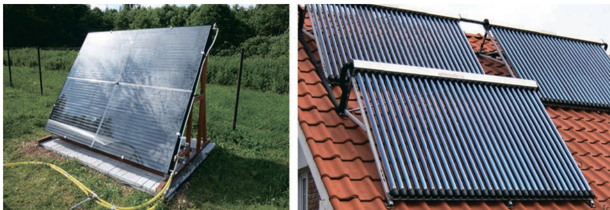
Рис. 4.14. Приклади встановлення сонячних колекторів для отримання гарячої води
