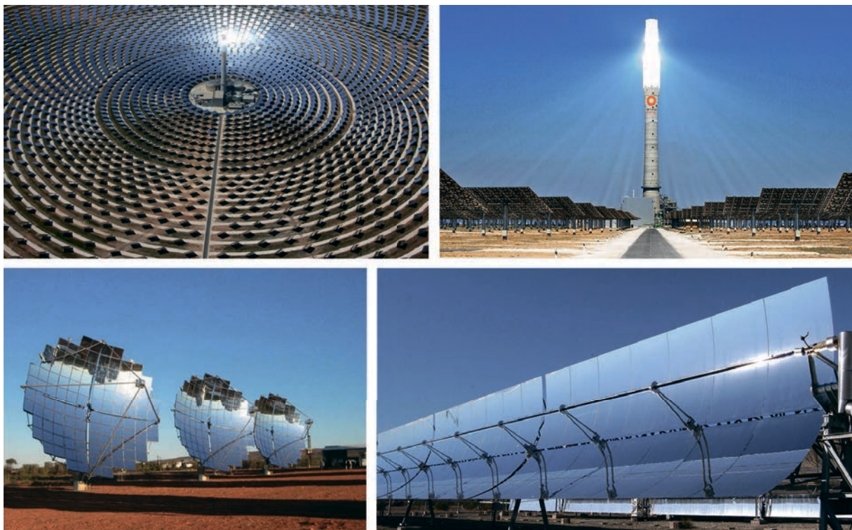
Рис. 4.10. СЕС баштового типу, тарілчасті та з параболічними концентраторами
