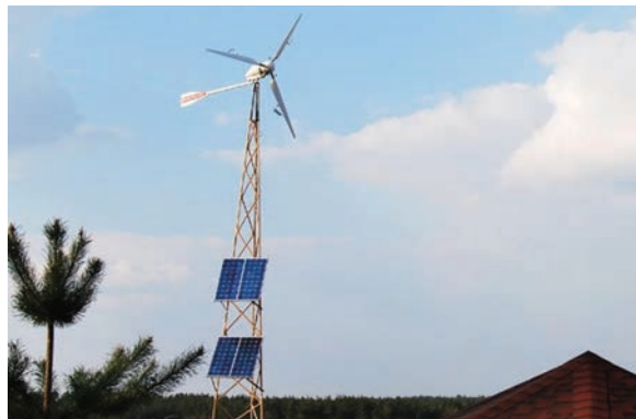
г) Приклад комбінованої вітро-сонячної генеруючої системи
