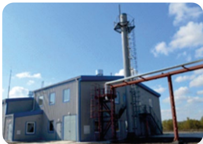
Парова котельня на тюкованій соломі компанії «Нива Переяславщини»
