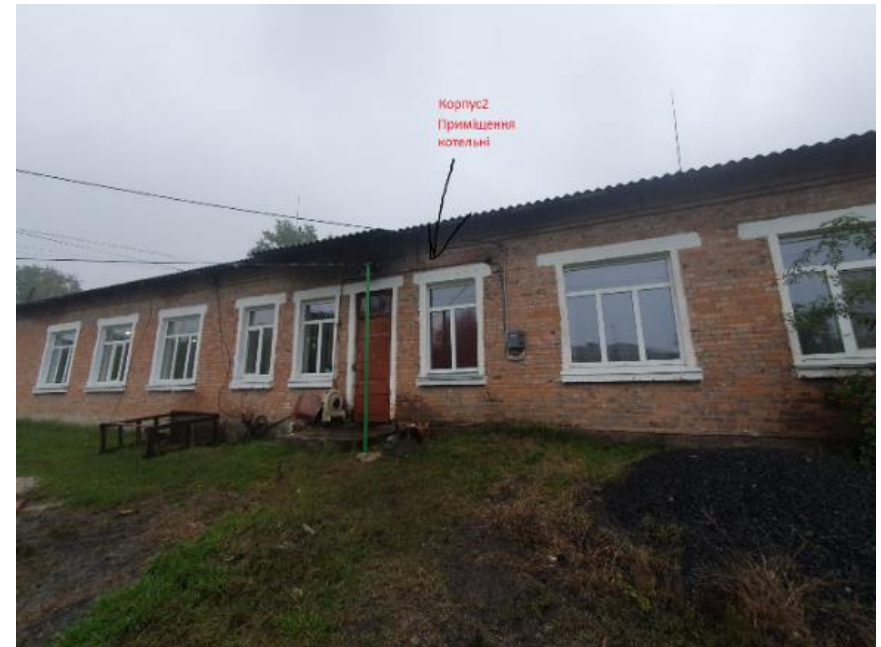
Зображення 2 Корпус 2, приміщення колишньої котельні
